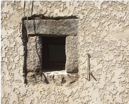
Enduit des façades trop épais par rapport aux pierres
