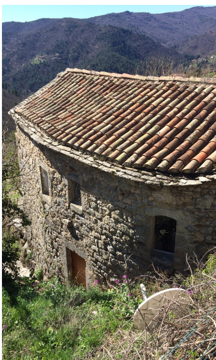
Habitation intégrée dans la pente
