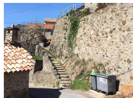
Escaliers encastrés dans la roche au lieu-dit les Hortals
