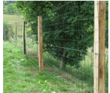
Clôture grillage souple et pieux de bois
