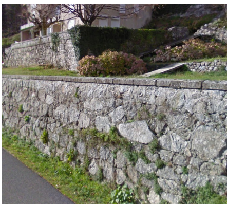
Mur de clôture créant soutènement
