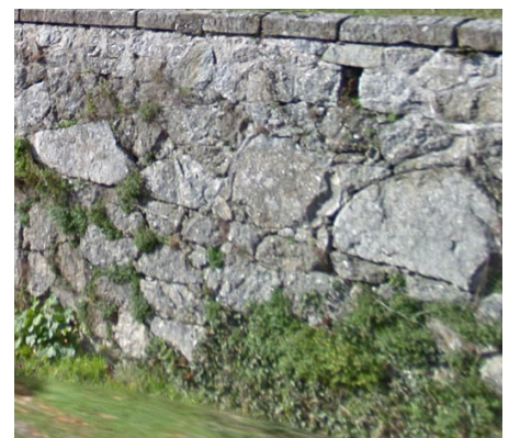
Clôture maçonnée créant soutènement
