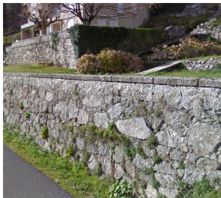
Mur de clôture créant soutènement
