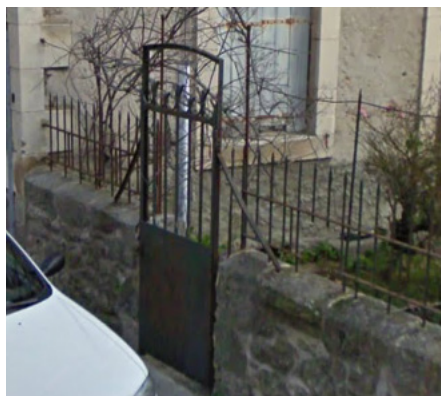
Mur bahut maçonné surmonté d'une grille à fers droits verticaux
