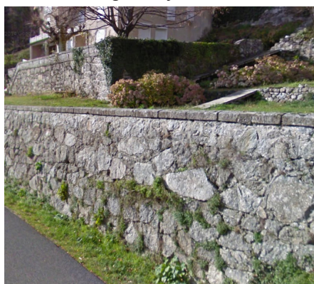
Mur de clôture créant soutènement
