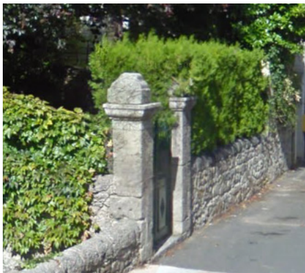
Clôture maçonnée couronnée de blocs de pierres de taille
