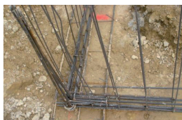
Noeud de chaînage - Continuité mécanique
