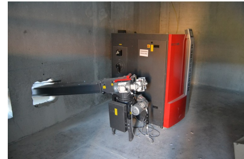
une des deux chaudières installées sur ce site
